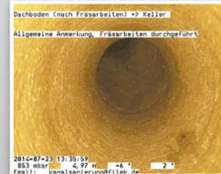
Besonders alte Leitungen leiden unter starken Inkrustationen und Fettablagerungen, wodurch der Durchfluss von Abwässern stark eingeschränkt wird.
